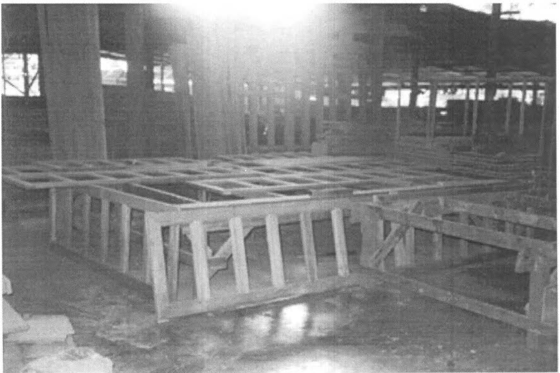
ภาพที่ 2.26 แสดงส่วนของโครงสร้างฝาเรือน
