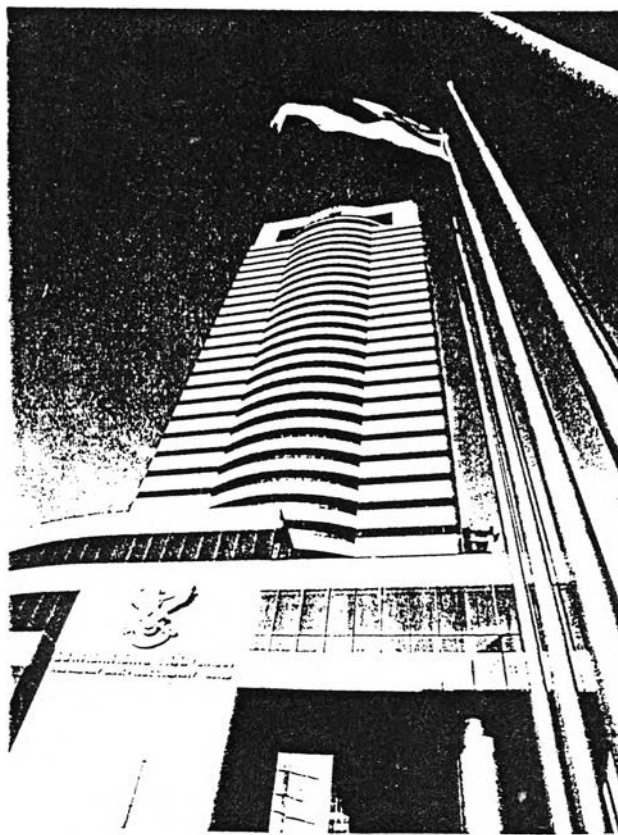
รูป 4.5 อาคารที่มีการเจาะช่องกระจก แบบที่ 1 และแบบที่ 3 ร่วมกัน ธนาคารทหารไทย จำกัด สำนักงานใหญ่ ถนนพหลโยธิน
