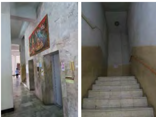
ภาพที่ 49 โถงลิฟต์ชั้นที่ 1 และบันไดทางขึ้นสู่ชั้นบน
