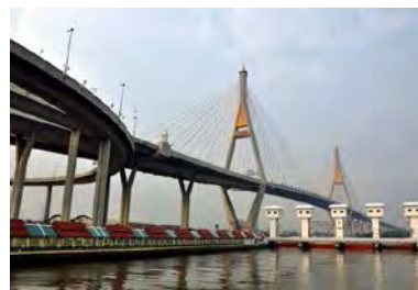
(ข.) สะพานคอนกรีตเสริมเหล็ก
