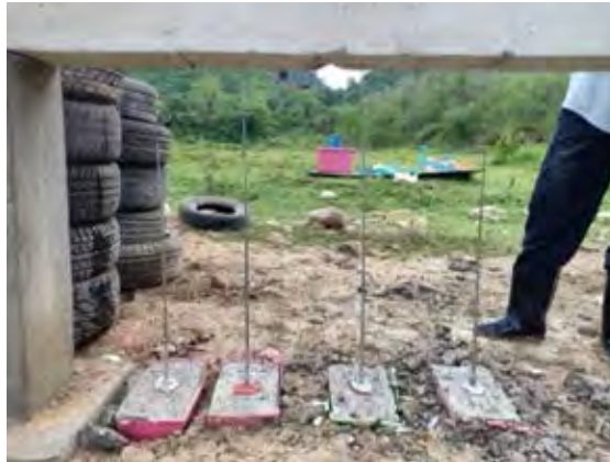
รูปที่ 36 ติดตั้งอุปกรณ์วัดการเคลื่อนตัวของเสา
