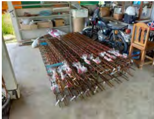
รูปที่ 25 การจัดเรียงตัวของเหล็กเสริมเหล็กปลอก และระยะการติด strain gauge
