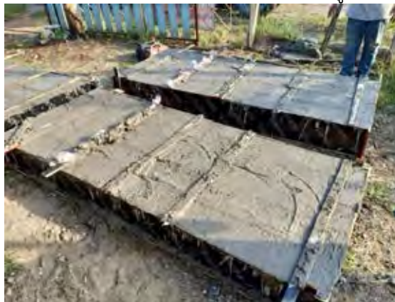
รูปที่ 27 การหล่อเสาคอนกรีตเสริมเหล็ก
