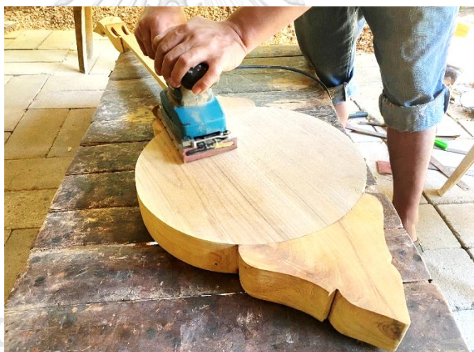
ภาพที่ 4.75 การใช้เครื่องจักรถึงขัดแต่งแผ่นหน้าตาตให้มีรอยต่อเรียบเนียนเสมอกับบัว ที่มาภาพ: ผู้วิจัยบันทึกภาพเมื่อวันที่ 17 พฤศจิกายน 2563
