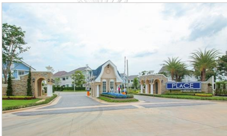
ภาพที่ 4.8 ทางเข้าโครงการ
