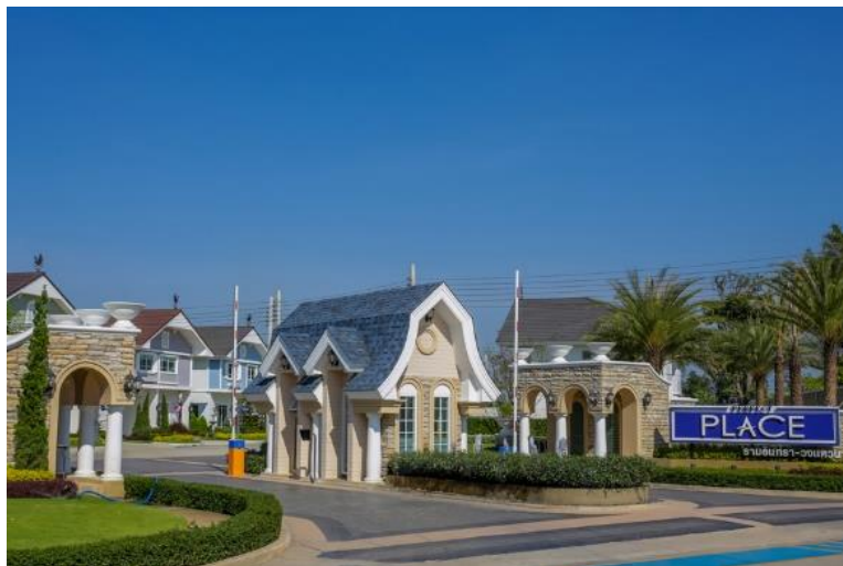
ภาพที่ 4.13 ทางเข้าโครงการ
