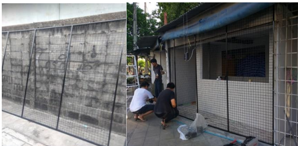
ภาพที่ 19 ลักษณะโครงสร้างเหล็ก
