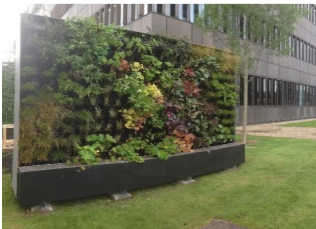
ภาพที่ 13 การติดตั้ง Green wall แบบใช้พืชหลากหลายสายพันธุ์ผสมผสานกัน
