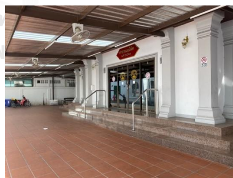
ภาพที่ 101 รววจับบริเวณศาลาอเนกประสงค์ภายในวัด
