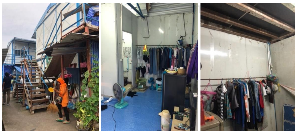
ภาพที่ 1.5 ที่พักอาศัยชั่วคราวที่มีการต่อเติมดัดแปลง
