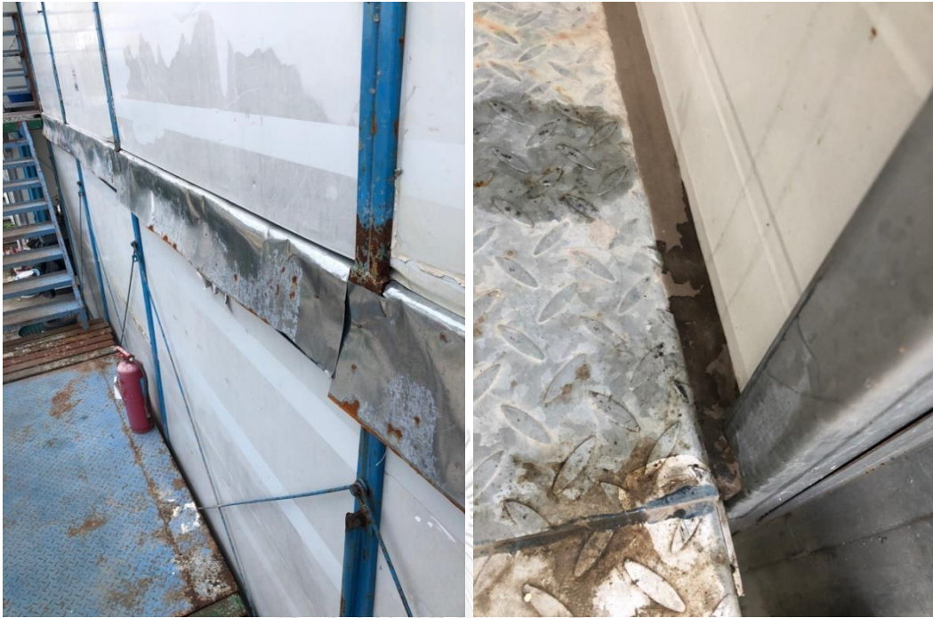
ภาพที่ 5.60 แสดงตัวอย่างบริเวณรอยต่อแผ่นผนังที่น้ำรั่ว
