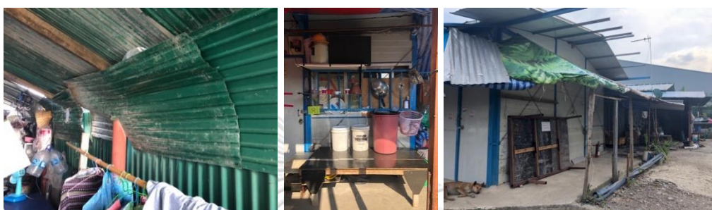
ภาพที่ 5.29 แสดงตัวอย่างการใช้วัสดุที่ใช้ในการตัดแปลงพื้นที่ ที่สามารถหาได้ตามหน่วยงานก่อสร้าง
