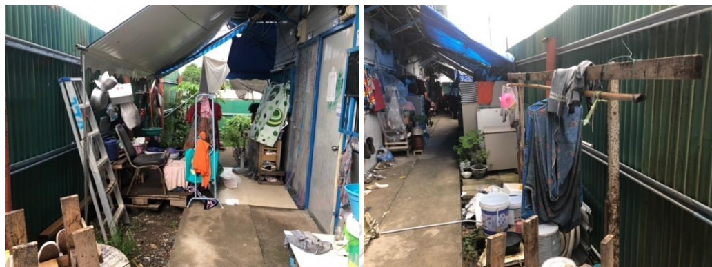
ภาพที่ 1.3 ที่พักอาศัยชั่วคราวที่มีการต่อเติมดัดแปลง
