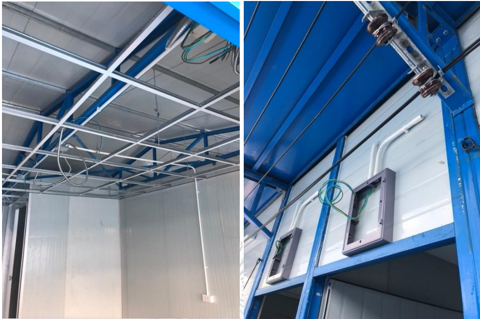
ภาพที่ 4.15 แสดงตัวอย่างช่วงรูปแบบสำเร็จรูปแบบถอดประกอบ
