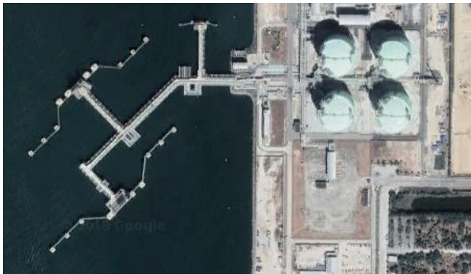
รูปที่ 3-7 แสดงโครงการก่อสร้างท่าเทียบเรือ และสถานีรับ-จ่ายก๊าซธรรมชาติเหลวมาบตาพุด ระยะที่ 2 (ที่มา: https://earth.google.com )
