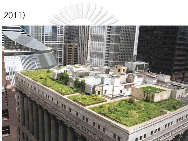
รูปที่ 2.8 หลังคาเขียวของอาคารศาลาว่าการของเมือง Chicago ที่มา: (Foster, J. และคณะ, 2011)
