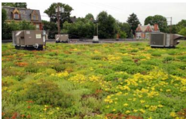
รูปที่ 2.3 หลังคาเขียวใน Lancaster, Pennsylvania, USA.
