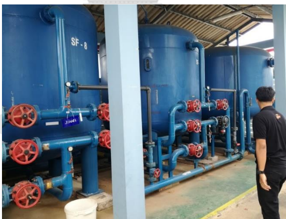
รูปที่ 4.1 วาล์ว Softener แบบ manual
