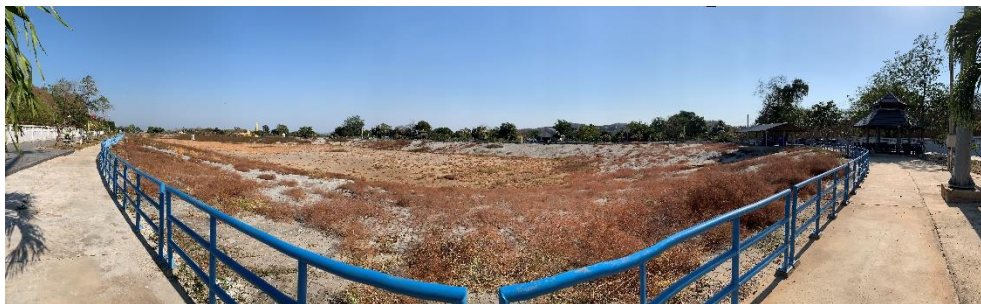
ภาพที่ 2-8 อ่างเก็บน้ำเทศบาลตำบลนเกาะสีชังหมู่ที่ 6
