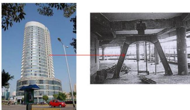
รูปที่ 2.2 Viscoelastic damper in Chaoshan Xinhe Building.
