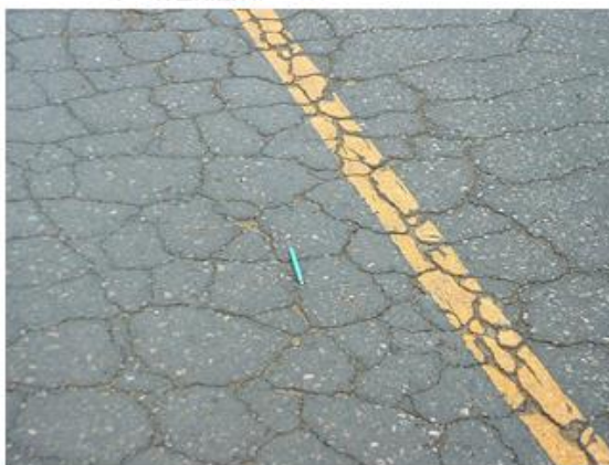
รูปที่ 2.10 การแตกร้าวเนื่องจากความล้ามีลักษณะแบบหนังจระเข้ [8]
