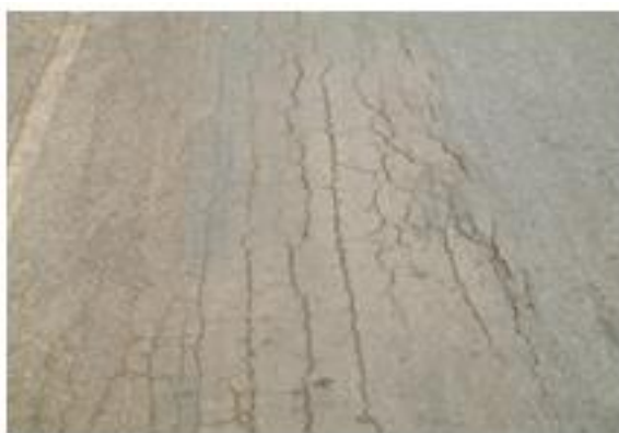
รูปที่ 2.11 การแตกร้าวเนื่องจากอุณหภูมิต่ำ [8]
