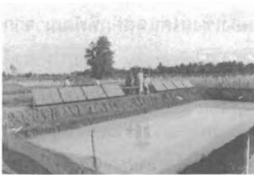
ระบบเซลล์แสงอาทิตย์ขนาด ๒ กิโลวัตต์ ติดตั้งที่บ่อเลี้ยงลูกปลาอุกที่บุรีรัมย์
