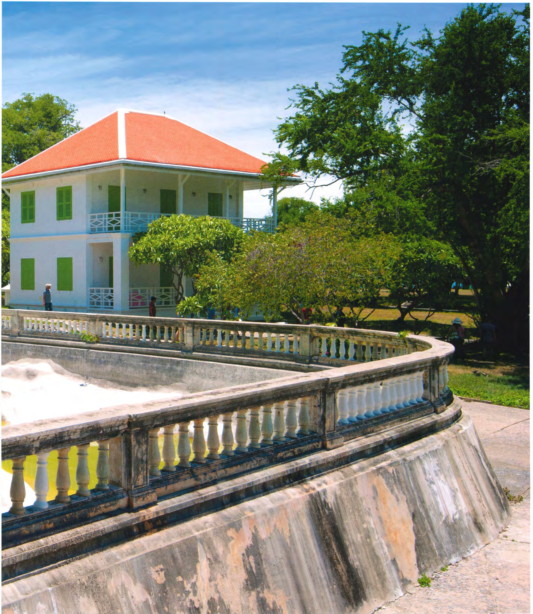
สร้างเสร็จในปี พ.ศ. ๒๔๓๒ เป็นอาคารก่ออิฐถือปูนสูงสองชั้น รูปสี่เหลี่ยมผืนผ้า ขนาดกว้าง ๘ เมตรยาว ๑๑ เมตร หลังคาทรงปั้นหยา มุงกระเบื้องเกล็ด ปัจจุบันจัดแสดงนิทรรศการเหตุการณ์สำคัญในเกาะสีชังสมัยรัชกาลที่ ๕ มีการบูรณะเมื่อปี พ.ศ. ๒๕๓๖ และ พ.ศ. ๒๕๔๖
