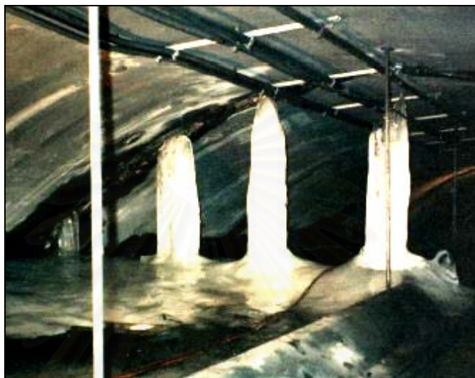
รูปที่ 2.1 การก่อตัวเป็นน้ำแข็งย่อยเหนือบะดานอุโมงค์ (FHWA และ FTA, 2003)
