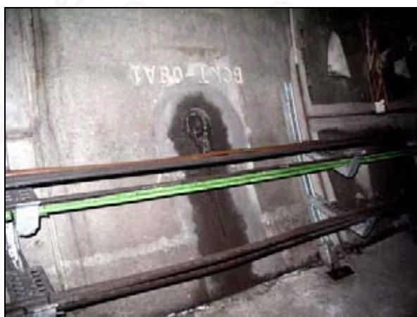
รูปที่ 4.14 การรั่วไหลของน้ำบริเวณรูฉีดย้ำปูน
