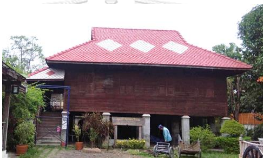
รูปที่ 129 ภาพก่อนการปรับปรุงหลังคาคุ้มเจ้ายอดเรือ พ.ศ.2564
