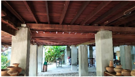
รูปที่ 140 การปรับปรุงโครงสร้างพื้นไม้ของคุ้มเจ้ายอดเรือน
