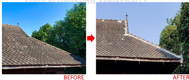
รูปที่ 127 การซ่อมแซมหลังคาบริเวณที่เสียหาย ปี พ.ศ.2564
