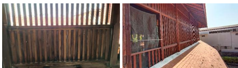
รูปที่ 148 การปรับปรุงผนังช่องลมภายนอกคุ้มเจ้าราชสัมพันธ์วงศ์
