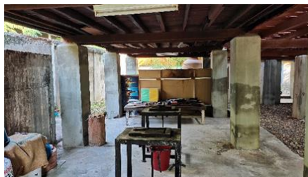
รูปที่ 125 การปรับปรุงผิวเสาชั้นล่างโดยการฉาบขี้ตม้น
