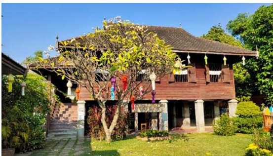
รูปที่ 128 ภาพก่อนการปรับปรุงหลังคาคุ้มเจ้ายอดเรือ ปี พ.ศ.2564
