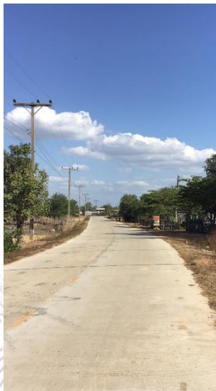
ถนนคอนกรีต
