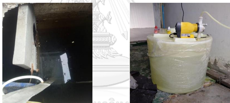
ภาพที่ 4.56 การเติมคอลรีนชนิดเข้มข้นในบ่อสุดท้าย เพื่อฆ่าเชื้อก่อนปล่อยลงสู่ลำรางสาธารณะ
