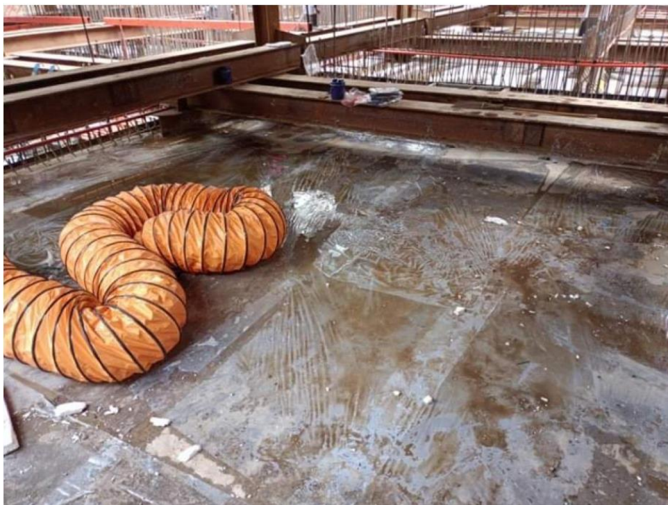
รูปที่ 3-37 ผิวบนของฐานรากแพซึ่งไม่พบรอยแตกร้าว
