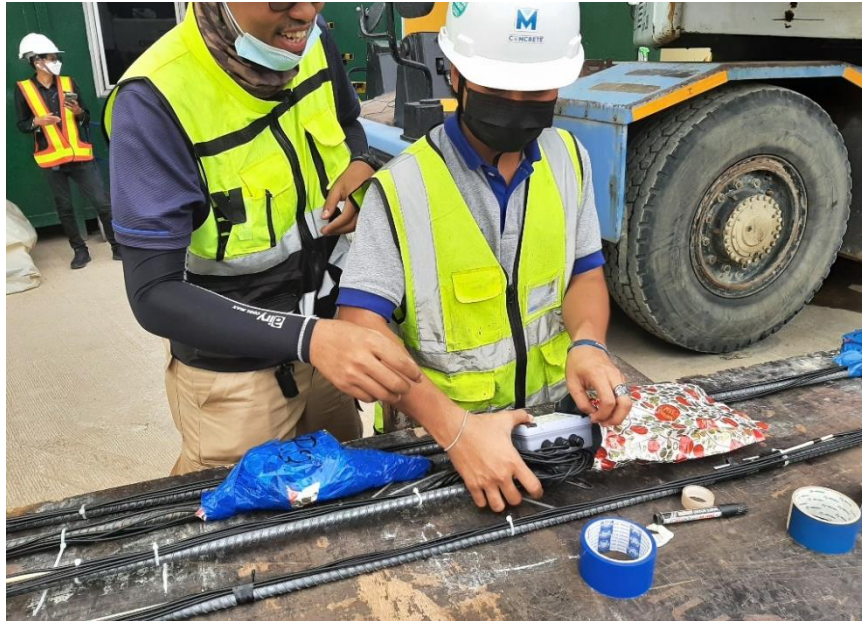
รูปที่ 3-29 การติดและคลุม Node ด้วยถุงพลาสติก
