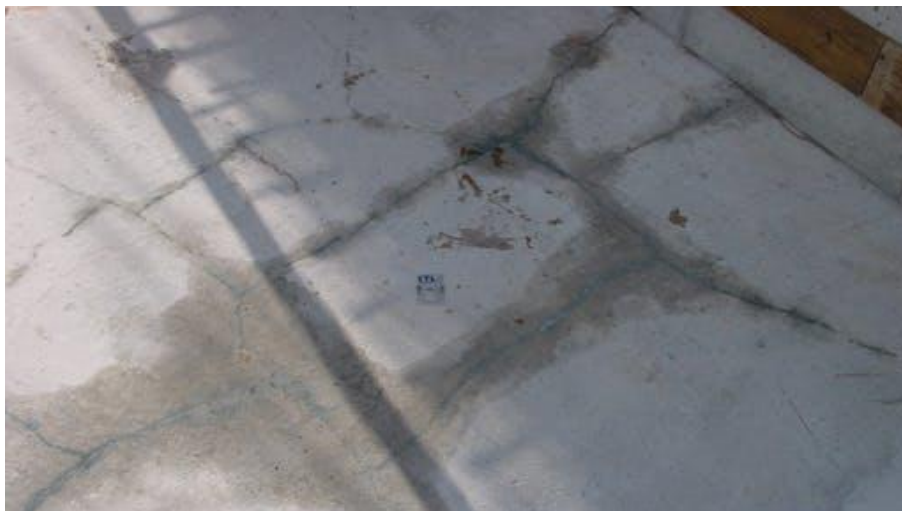
รูปที่ 1-2 รอยแตกร้าวที่ผิวข้างของคอนกรีต ซึ่งเป็นผลมาจากผลต่างอุณหภูมิของแกนกลางและผิวคอนกรีตมีค่ามาก (Gajda & Nasvik, 2017)
