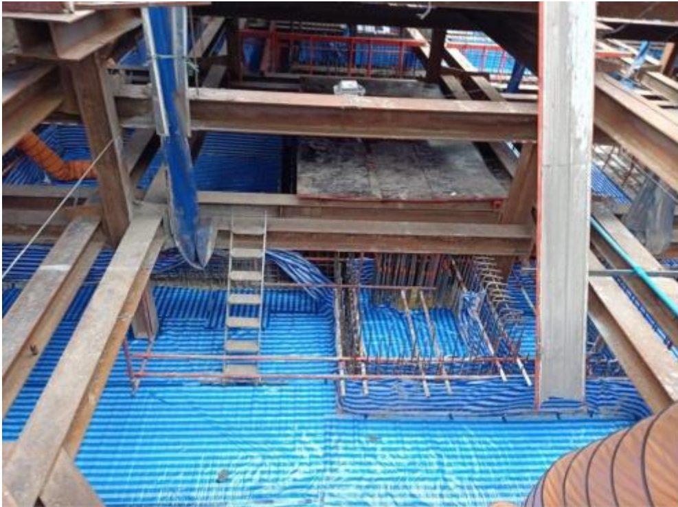
รูปที่ 3-35 ฐานรากแพที่มีการปิดโฟมและผ้าใบ เพื่อเป็นฉนวนความร้อน
