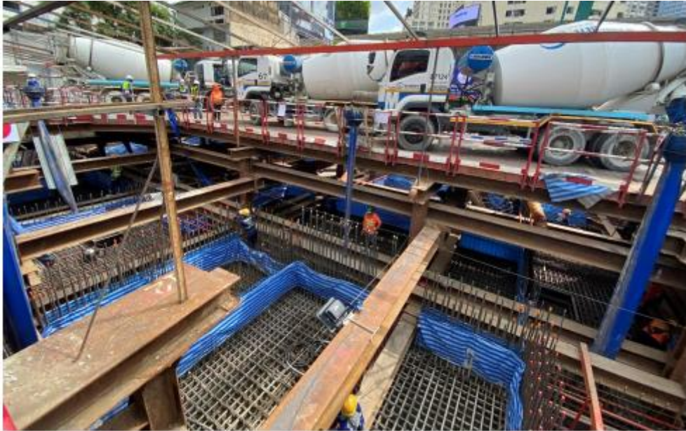
รูปที่ 3-33 ฐานรากแพะขณะเทคอนกรีต
