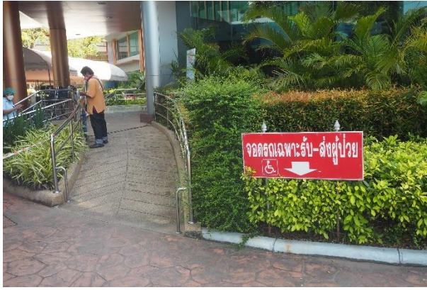
รูปที่ 1 ทางลาด ณ คลินิกอบอุ่นของเทศบาลนครระยอง
