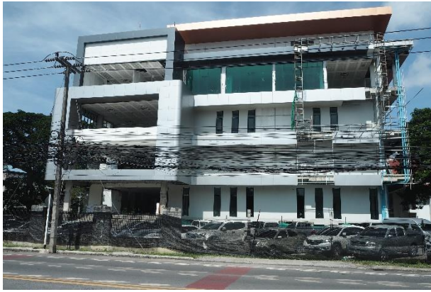
รูปที่ 7 อาคารเทศบาลนครระยองแห่งใหม่
