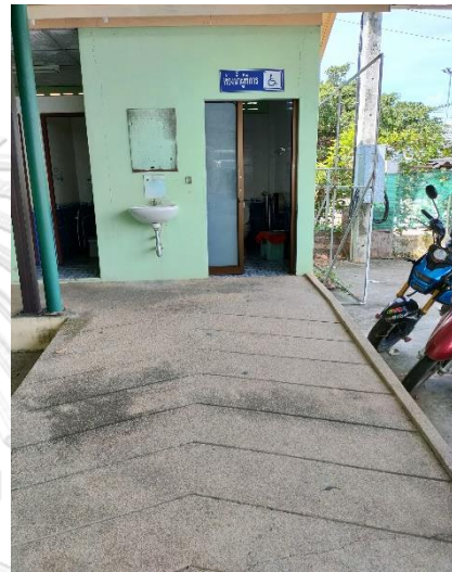
รูปที่ 10 ห้องน้ำสำหรับผู้สูงอายุ
