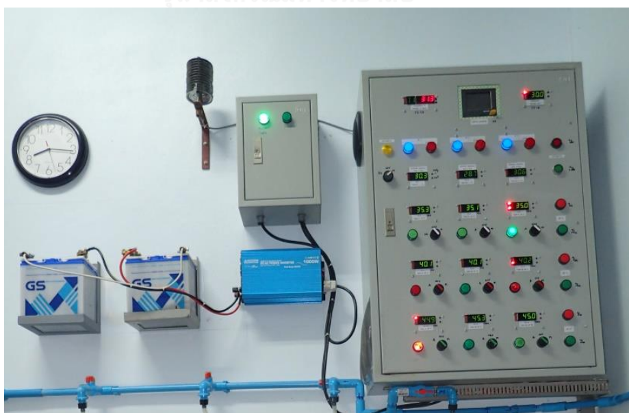
รูปที่ 3.6 เครื่องควบคุมอุณหภูมิและความชื้น
