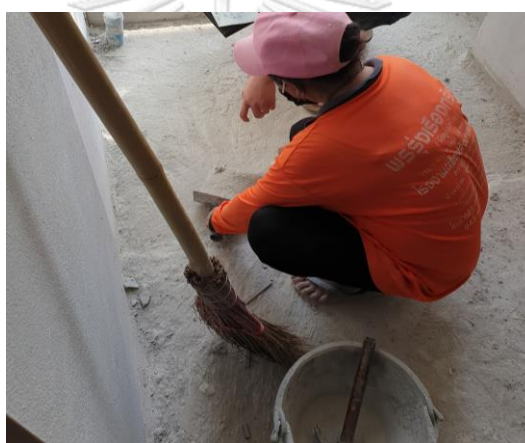
รูปที่ 5.25 รูปภาพแสดงกิจกรรมก่อสร้างในโครงการกรณีศึกษาที่ 3 (งานกวาดฝุ่น และเก็บขี้ปูน)
