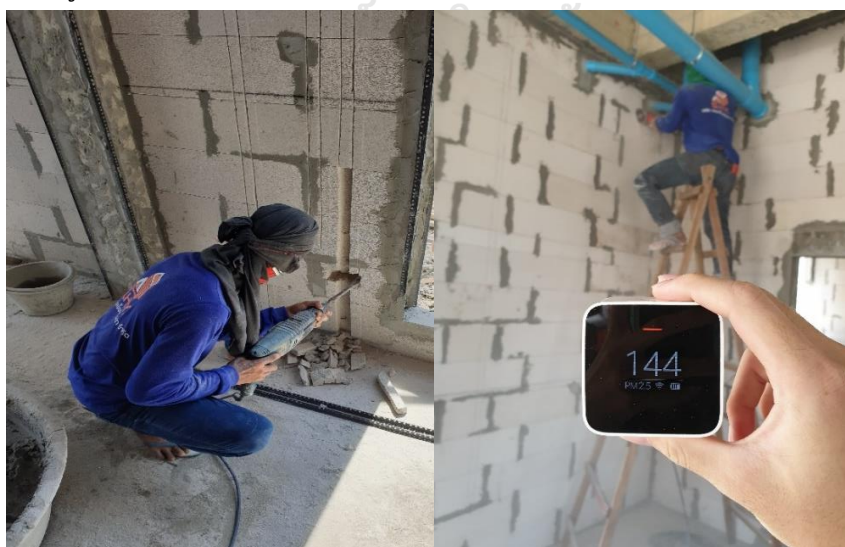
รูปที่ 5.2 รูปภาพแสดงกิจกรรมก่อสร้างในโครงการกรณีศึกษาที่ 1 (กิจกรรมสกัด เซาะร่องผนัง)
