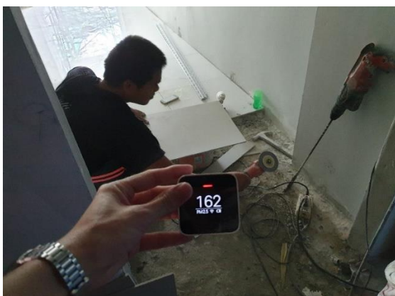
รูปที่ 5.24 รูปภาพแสดงกิจกรรมก่อสร้างในโครงการกรณีศึกษาที่ 3 (กิจกรรมปูกระเบื้อง ตัดกระเบื้อง)
