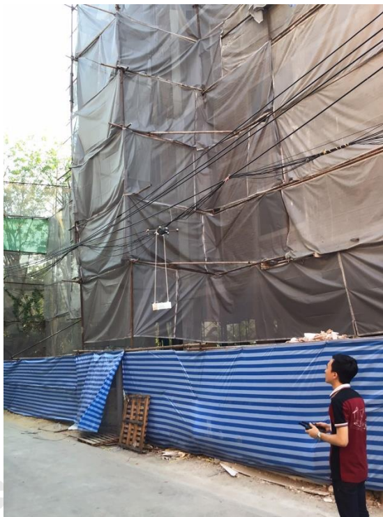
รูปที่ 5.27 รูปภาพแสดงขณะทำการบินวัดปริมาณฝุ่นละอองบริเวณรอบๆของอาคารที่ทำการก่อสร้าง (โครงการกรณีศึกษาที่ 3)
