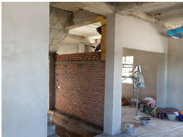
รูปที่ 5.15 รูปภาพแสดงกิจกรรมก่อสร้างในโครงการกรณีศึกษาที่ 2 (กิจกรรมก่ออิฐ)
