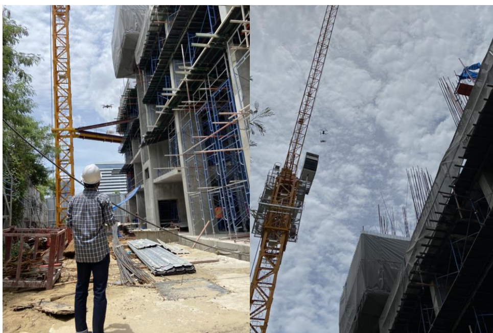
รูปที่ 5.35 รูปภาพแสดงขณะทำการบินวัดปริมาณฝุ่นละอองบริเวณรอบๆของอาคารที่ทำการก่อสร้าง (โครงการกรณีศึกษาที่ 4)
