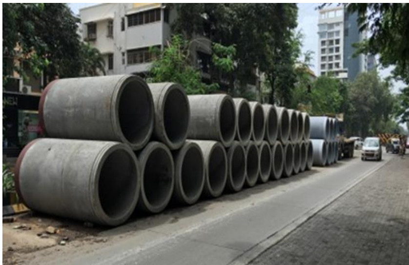
รูปที่ 1.3 ท่อดัน (Jacking Pipes)
