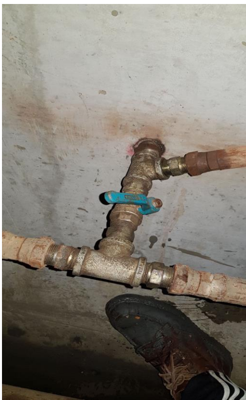
รูปที่ 4.12 วาล์วควบคุมการไหลของสารหล่อลื่นในแต่ละ lubrication pipe
