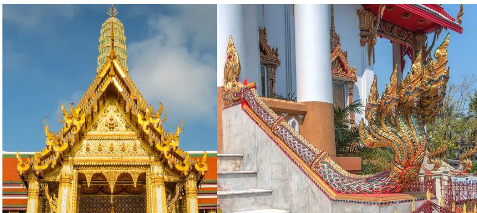
ภาพที่ 4.11 (ซ้าย) เครื่องหลังคาอันประกอบด้วยช่อฟ้า ใบระกา ทางหงส์ ลายรวงผึ้ง ณ วัดพระศรีรัตนศาสดาราม (ขวา) บันไดนาค ณ วัดดอกไม้ ที่มาภาพ: (ซ้าย) https://bit.ly/3xKthpl (ขวา) https://bit.ly/3U5QoUG
