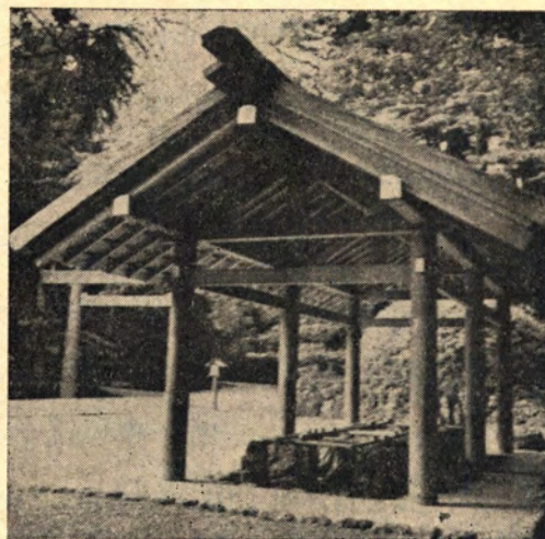
P. 28 แสดงโครงสร้างง่าย ๆ แบบ POST และ BEAM
