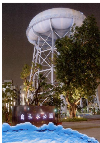
ภาพที่ 8 หอเก็บน้ำ
