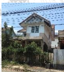
ภาพที่ 9.13 ก่อนการปรับปรุงบ้านหลังที่ 3
