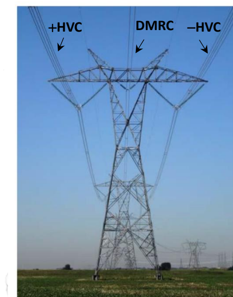
รูปที่ 2.2 รูปแบบสายส่ง \pm 800 kV แบบขั้วคู่ที่มีตัวนำไฟฟ้า DMRC [4]
