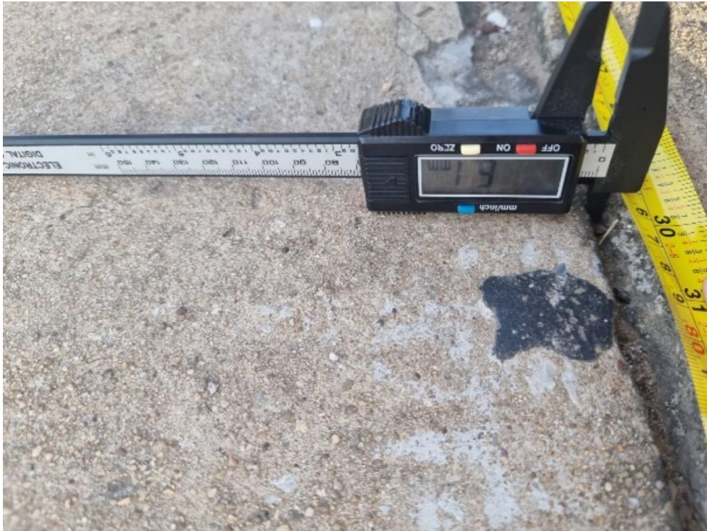
รูปที่ 146 การวัดขนาดความกว้างรอยต่อทางเท้าบริเวณรอยต่อที่ 2 เสาดม่อที่ 1
