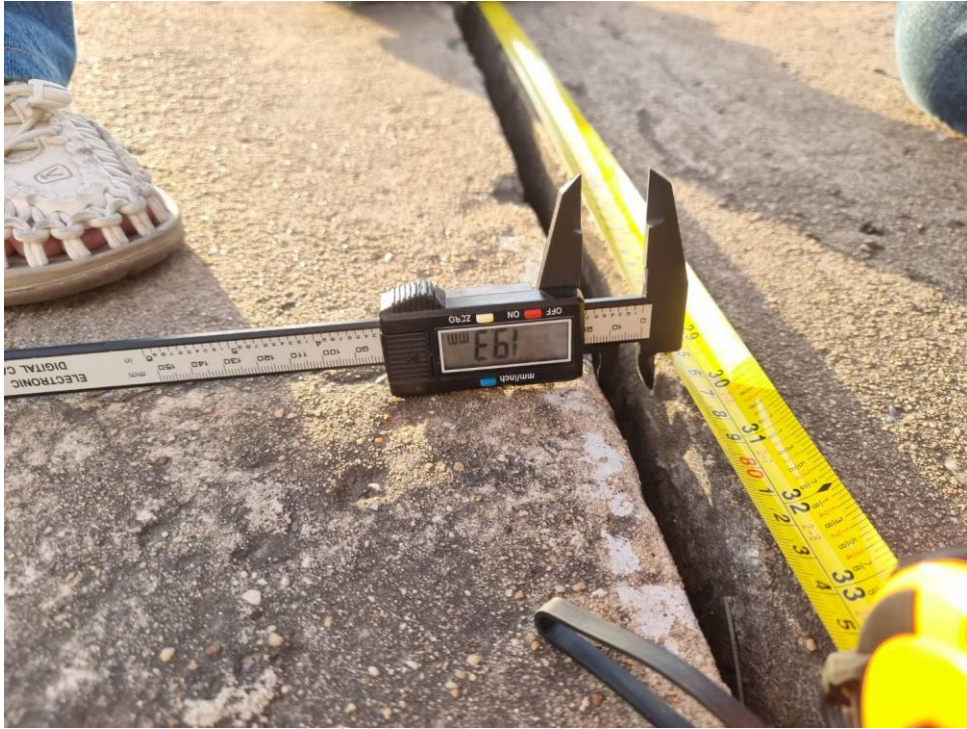
รูปที่ 154 การวัดขนาดความกว้างรอยต่อทางเท้าบริเวณรอยต่อที่ 1 เขตจอมทองที่ 6
