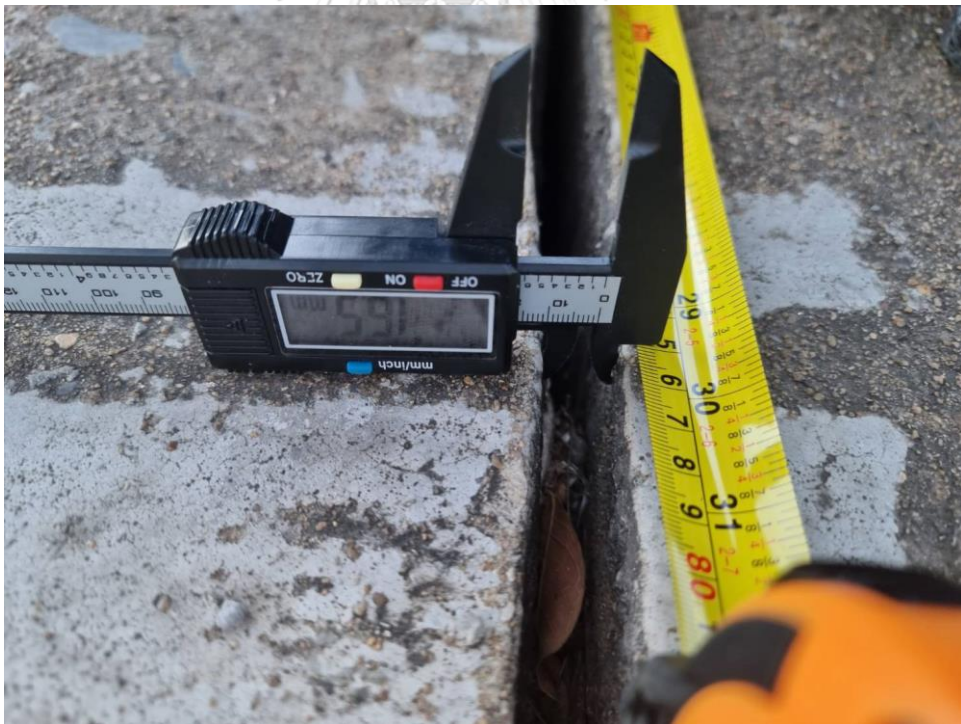
รูปที่ 155 การวัดขนาดความกว้างรอยต่อทางเท้าบริเวณรอยต่อที่ 1 เขตจอมทองที่ 5
