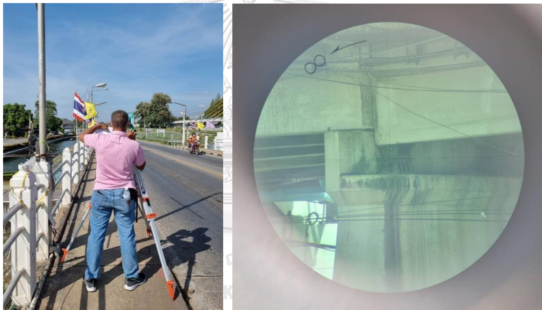
รูปที่ 36 การรังวัดค่าพิกัดของจุดที่เห็นเด่นชัดบนพื้นผิวสะพาน
