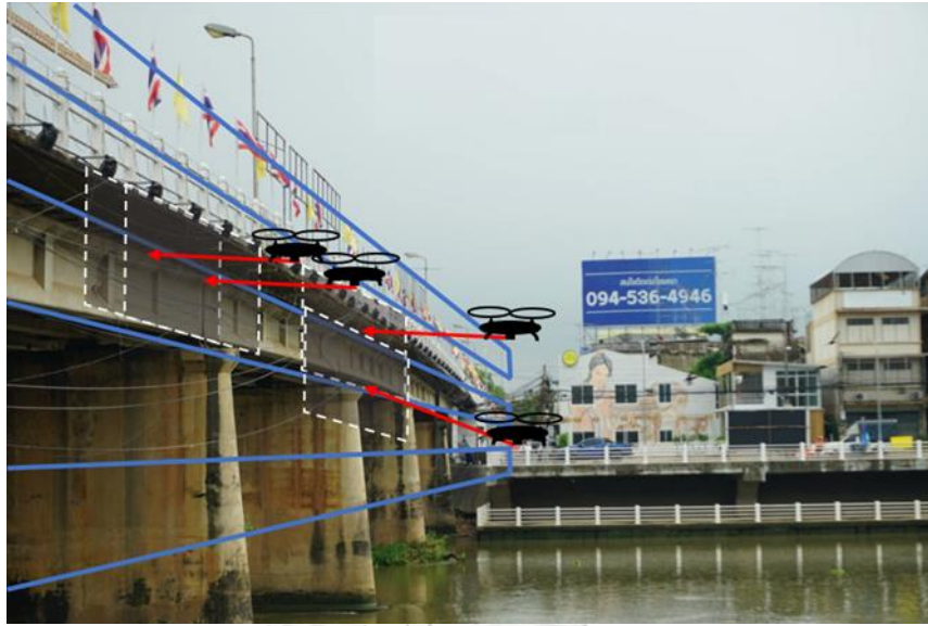
รูปที่ 41 ตัวอย่างเส้นทางการบินด้านข้างของสะพาน
