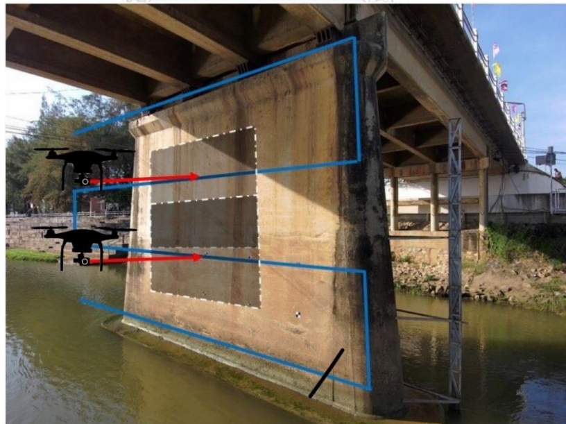
รูปที่ 42 ตัวอย่างเส้นทางการบินกำแพงตอม่อและการส่วนซ้อน (Overlap)
