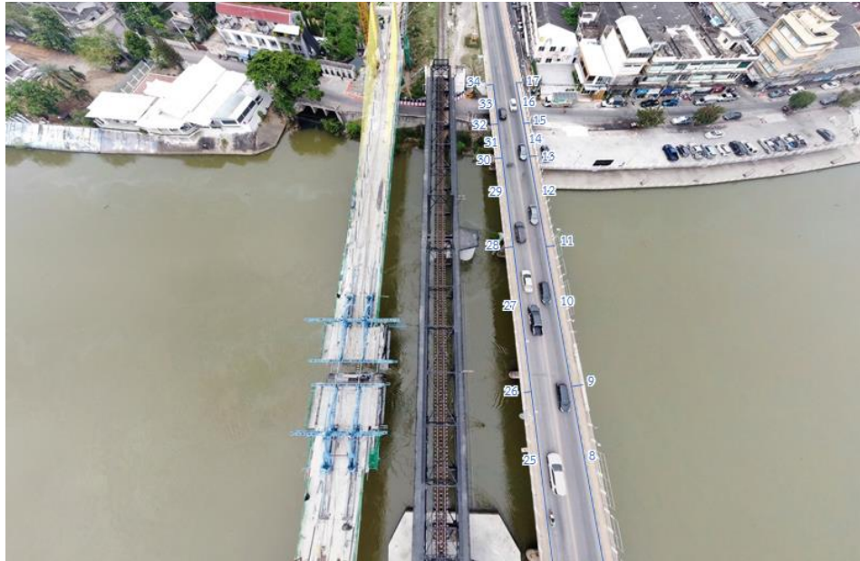
รูปที่ 48 เส้นทางตรวจสอบระยะแต่ละส่วนของสะพานฝั่งตลาดราชบุรี
