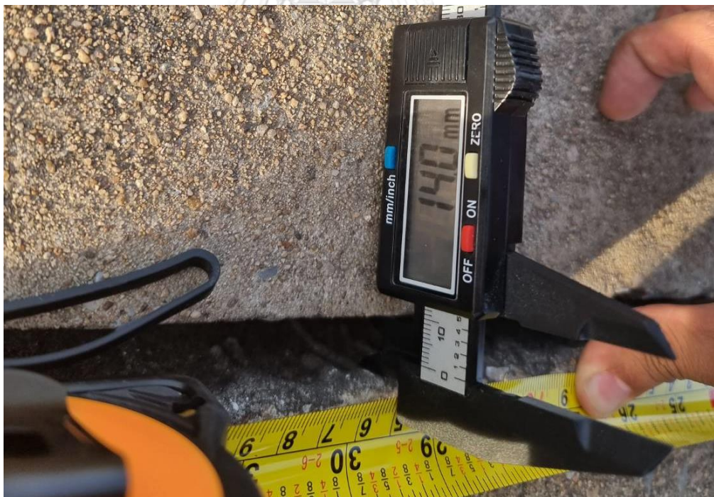
รูปที่ 147 การวัดขนาดความกว้างรอยต่อทางเท้าบริเวณรอยต่อที่ 2 เสาดม่อที่ 2
