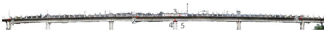
รูปที่ 71 ตำแหน่งการหลุดหล่อนของสะพานคอนกรีตเสริมเหล็กส่วนข้างของสะพานฝั่งแม่น้ำ
