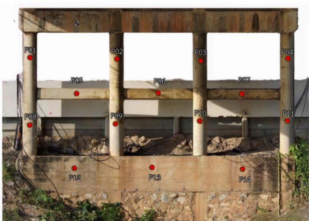
รูปที่ 54 จุดที่เห็นเด่นชัดส่วนเสาตอม่อที่ 1
