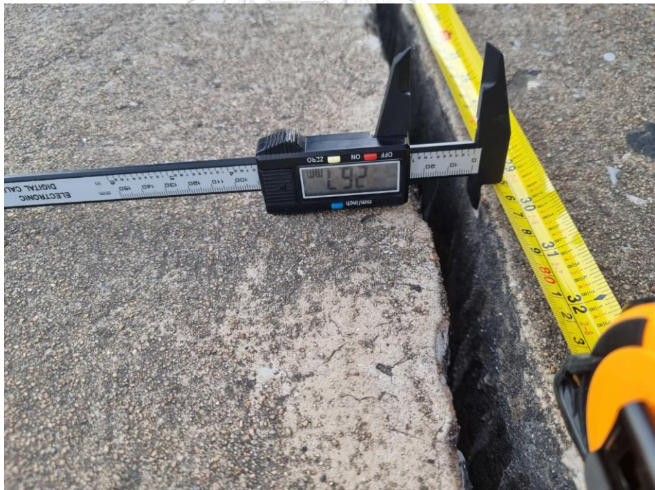
รูปที่ 157 การวัดขนาดความกว้างรอยต่อทางเท้าบริเวณรอยต่อที่ 1 เสาดม่อที่ 3
