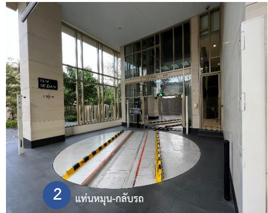
ภาพที่ 94 แท่นหมุนรถบริเวณทางเข้า-ออกลิฟต์ 2 (ปรับปรุง)
