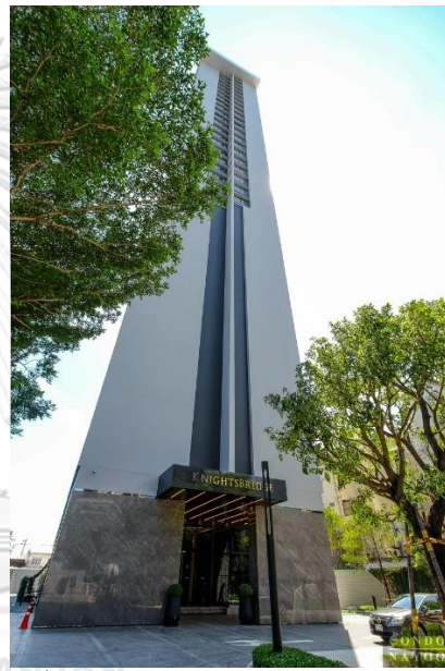
ภาพที่ 59 ด้านหน้าโครงการ ไนท์บริดจ์ไพรม์ อ่อนนุช
