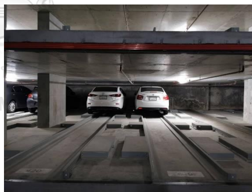
ภาพที่ 64 ภายในช่องจอดรถอัตโนมัติพื้นคอนกรีต ที่มา: Condonayoo (2563)
