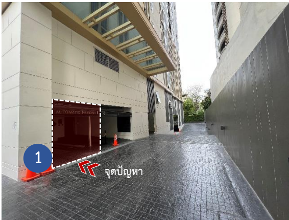
ภาพที่ 93 ทางเข้าแบบเลี้ยว 90 องศาเข้าจอดเทียบในช่องจอดลิฟต์
