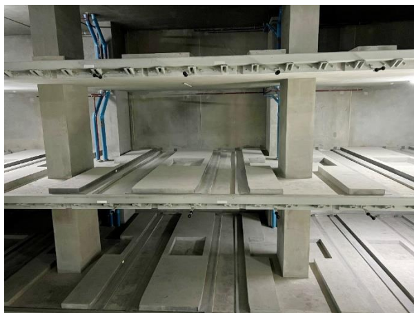
ภาพที่ 85 ภายในช่องจอดรถอัตโนมัติพื้นคอนกรีต
