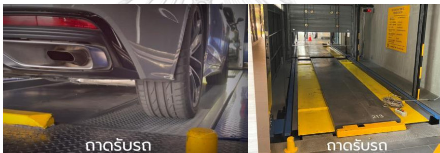
ภาพที่ 6 ลักษณะของถาดรับรถของที่จอดรถอัตโนมัติแบบรองรับรถด้วยถาด (Pallet Type)
