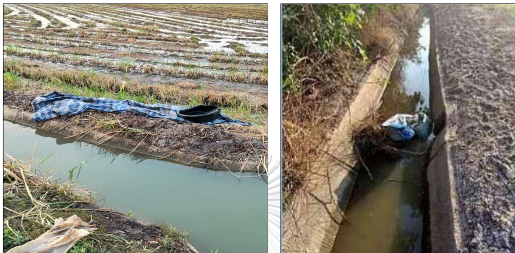
ภาพการกีดขวางคลองชลประทานเพื่อนำน้ำเข้ามา ถ่ายโดยชาวบ้านในพื้นที่
