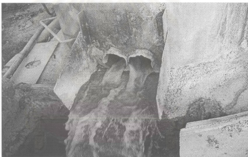
รูปที่ 2.13 เถ้าลอยที่ถูกกำจัดจากโรงงานผลิตแอสฟัลท์คอนกรีต (ผดุงสิน ธนศรีวินิชชัย, 2549)
