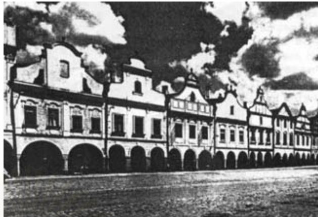
ภาพ 2.13 ความต่อเนื่องระหว่างอาคารจากการวางหน้าต่างไปในแกนเดียวกัน
