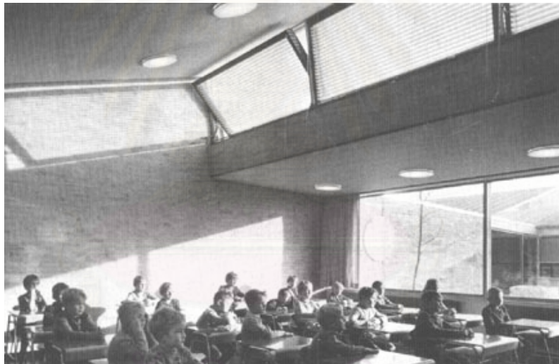
ภาพที่ 2.34 บรรยากาศห้องเรียนที่ใช้ช่องแสงแบบ Clerestory ที่มา: Alfred Roth. New school building . London: Thomas & Hudson, 1966.
