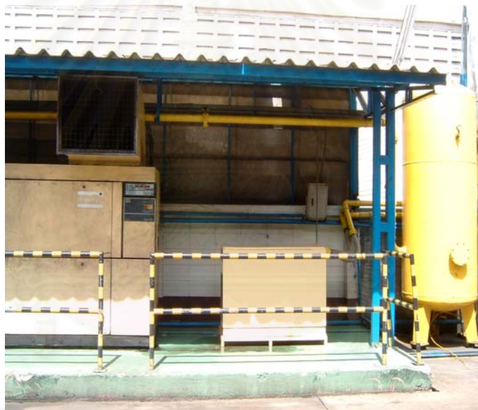
รูปที่ 3.5 แสดง Air Supply Unit ของโรงงาน
