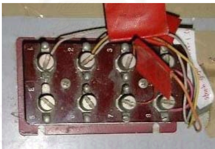
รูปที่ ค5 Bridge box ที่ใช้กับ Strain amplifier ตำแหน่ง 2
