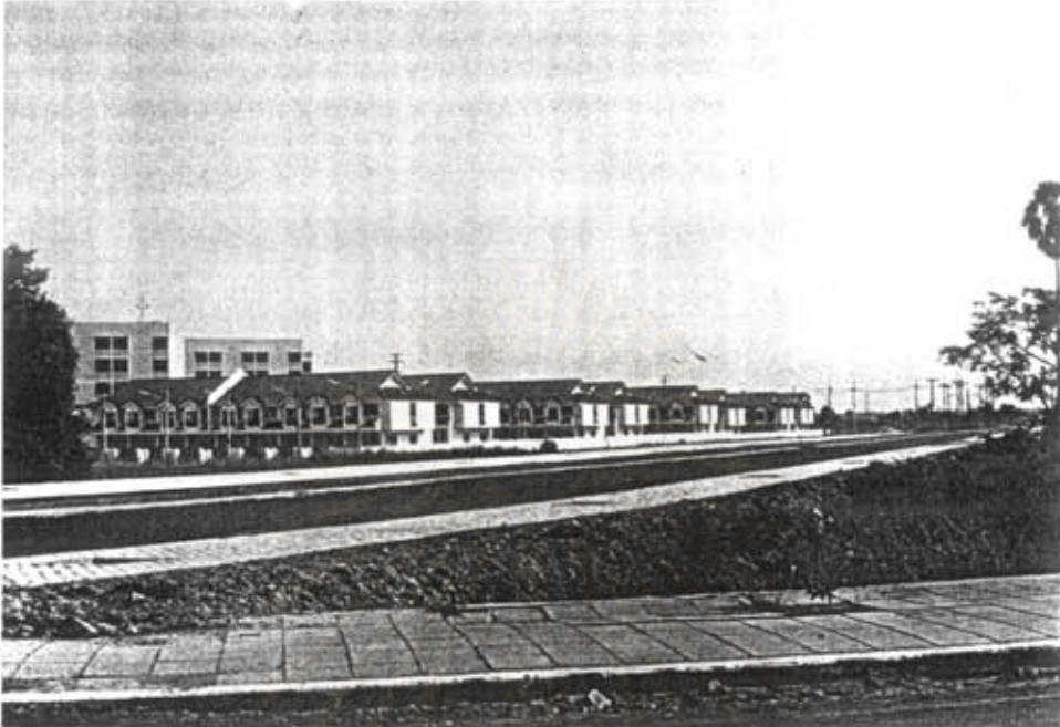
ภาพที่ 29 ถนนภายในโครงการเคหะชุมชนแหลมฉบัง
