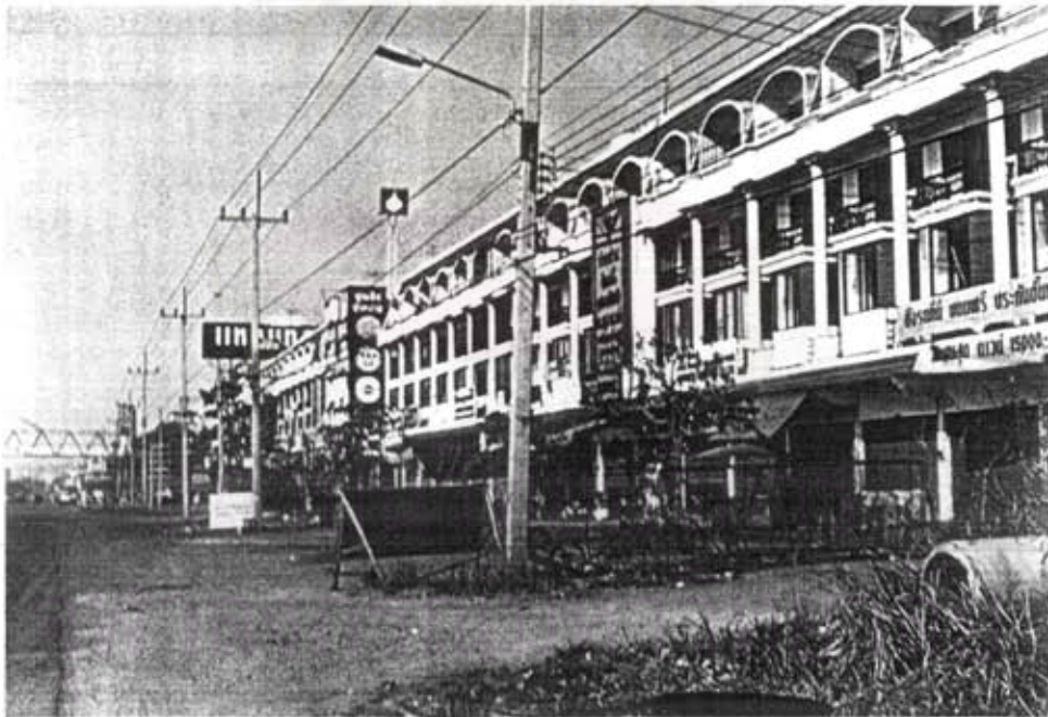
ภาพที่ 24 อาคารพาณิชย์ บริเวณศูนย์การค้าแหลมทองคอมเพล็กซ์ ต.ทุ่งสุขลา อ.ศรีราชา
