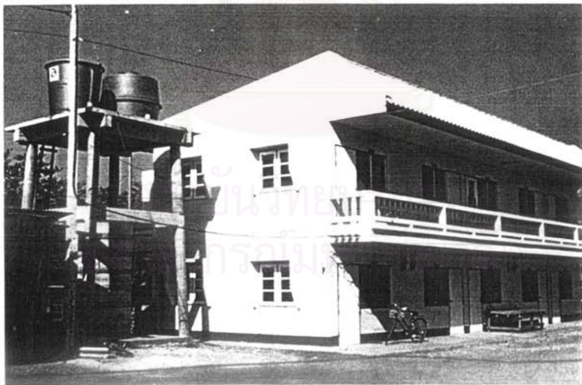
ภาพที่ 10 อาคารที่พักอาศัยแบบเรือนแถวยาว 2 ชั้น แบ่งเช่า ในซอยวัดอุสภาราม (วัดบางวัว) ต.บางวัว อ.บางปะกง จ. ฉะเชิงเทรา
