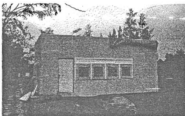
ภาพที่ 3.2 อาคารทดลอง
