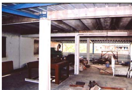
ภาพที่ 4-20 แสดงส่วนแก้ไขความสูงและงานโครงสร้างหลังคา
