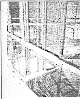
ภาพที่ 3-62 แสดงรูปแบบติดตั้งโครงลิฟต์อลูมิเนียมและเหล็กบริเวณเสาและคานภายในตึกแถวสยามสแควร์
