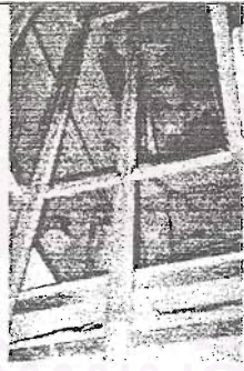
ภาพที่ 3-62 แสดงรูปแบบติดตั้งโครงลิฟต์อลูมิเนียมและเหล็กบริเวณเสาและคานภายในตึกแถวสยามสแควร์
