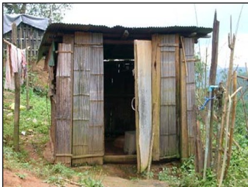
รูปที่ 5.47 ห้องน้ำ-ห้องส้วมของหลังคาเรือนที่ 8 มีผู้มาใช้รวมมาก ที่สุตรวม 3 หลัง
