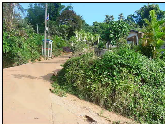
รูปที่ 4.16 ถนนคอนกรีตเสริมเหล็กสายหลัก
