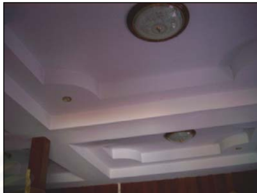
รูปที่ 5.37 ฝ้ายิปซัมบอร์ด
