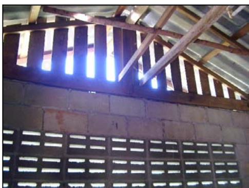
รูปที่ 5.42 ไม้จริงตีเว้นร่องเพื่อระบายควันไฟภายในครัว
