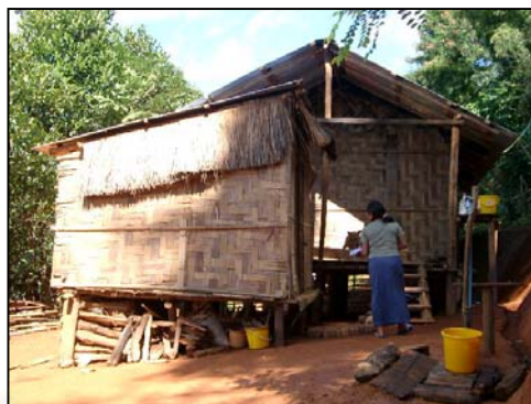
รูปที่ 5.45 ครั้วผนังฟาก หลังคาหญ้าคา
