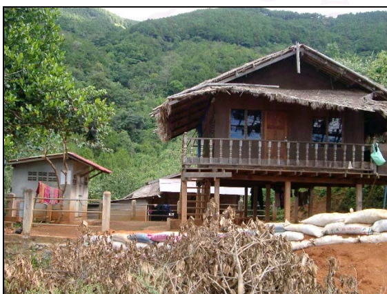
รูปที่ 4.31 เรือนประยุกต์วัสดุกิ่งถาวรชั้นเดียวยกใต้ถุนสูง
