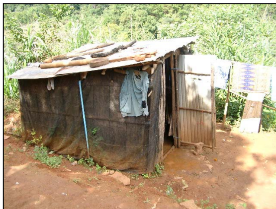
รูปที่ 5.63 ผนังห้องน้ำใช้ตาข่ายมาช่วยบังสายตา
