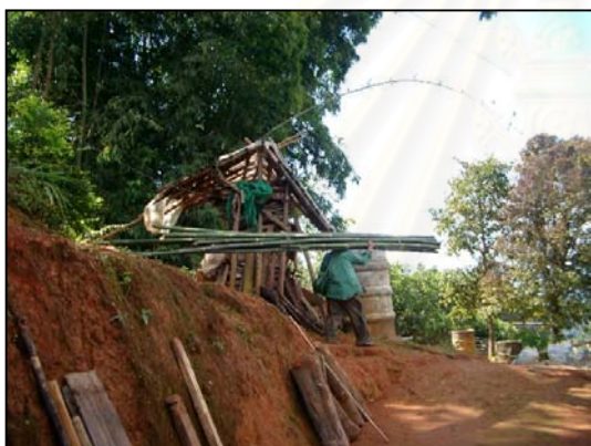
รูปที่ 5.11 การขนไม้ไผ่จากป่าเพื่อนำมาสร้างเรือน
