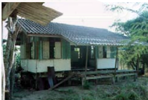
รูปภาพที่ 17 อาคารอนุบาลหลังใหม่ อยู่ในช่วงระหว่างการปรับปรุง
