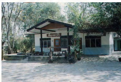
รูปภาพที่ 16 อาคารอนุบาลหลังเก่าซึ่งตั้งอยู่บนทางน้ำ
