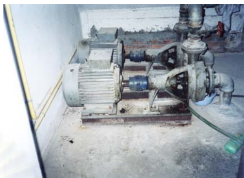
ภาพที่ 3.13 แสดงภาพถ่าย เครื่องปั้มน้ำ
