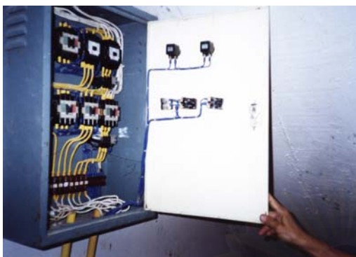
ภาพที่ 3.12 แสดงภาพถ่าย ระบบควบคุมการทำงานเครื่องปั้มน้ำ
