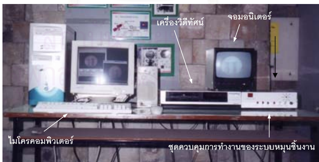
รูปที่ 4.2 ระบบเก็บข้อมูลภาพถ่ายด้วยนิวตรอนโดยเทคนิคโทรทัศน์ สำหรับส่วนที่ติดตั้งภายนอกห้องกำบังรังสี
