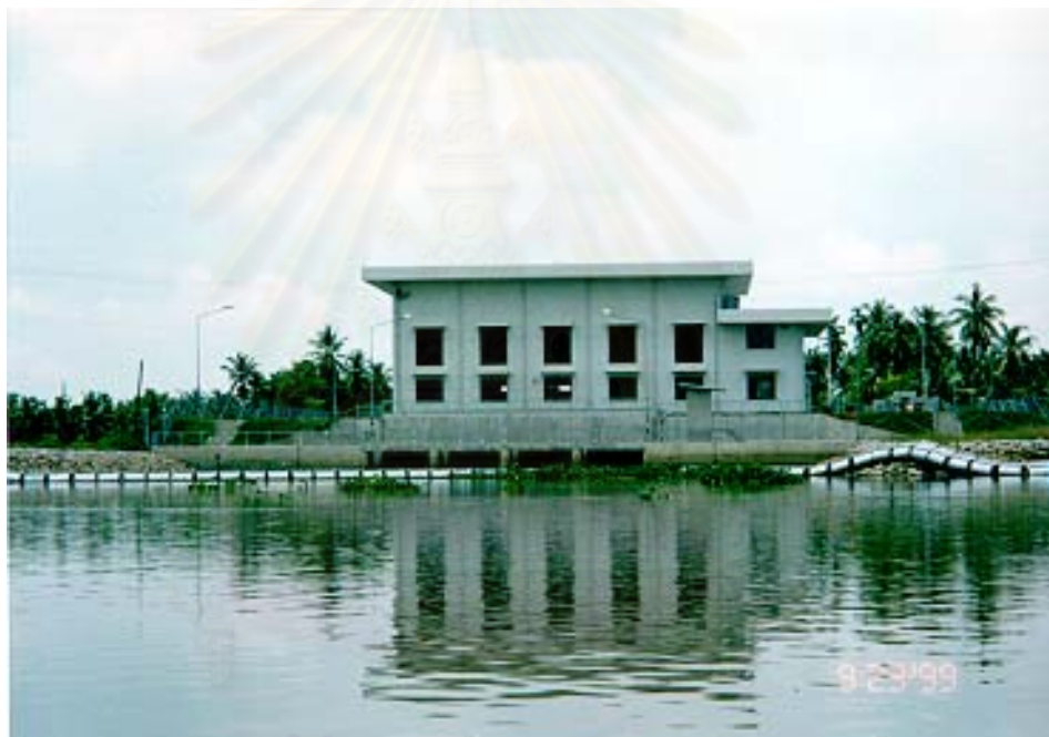
รูป 3-7 สถานีสูบน้ำ ของโครงการเขื่อนทดน้ำบางปะกง
