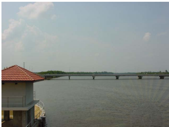
รูปที่ ง-2 สถานีโทรมาตรท้ายเขื่อนทดน้ำบางปะกง
