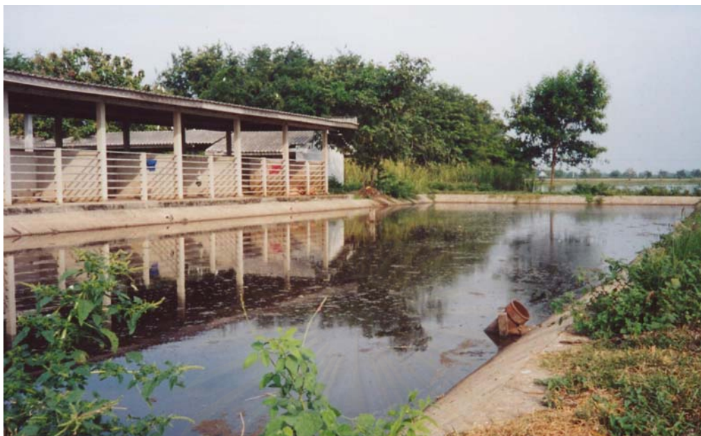
รูปที่ 3.2 ป้อมหักไร้อากาศของโรงฆ่าสัตว์เทศบาลเมืองสุพรรณบุรี
