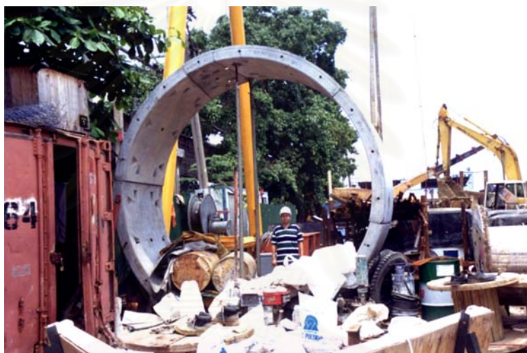
รูปที่ 3.2 ลักษณะของอุโมงค์หลังจากการประกอบชิ้นส่วน Segment ทั้ง 7 ชั้นเข้าด้วยกัน
