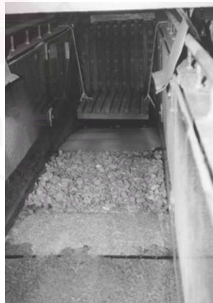
รูป ก-3 ตะแกรงกันคลื่น (wave suppressors)
